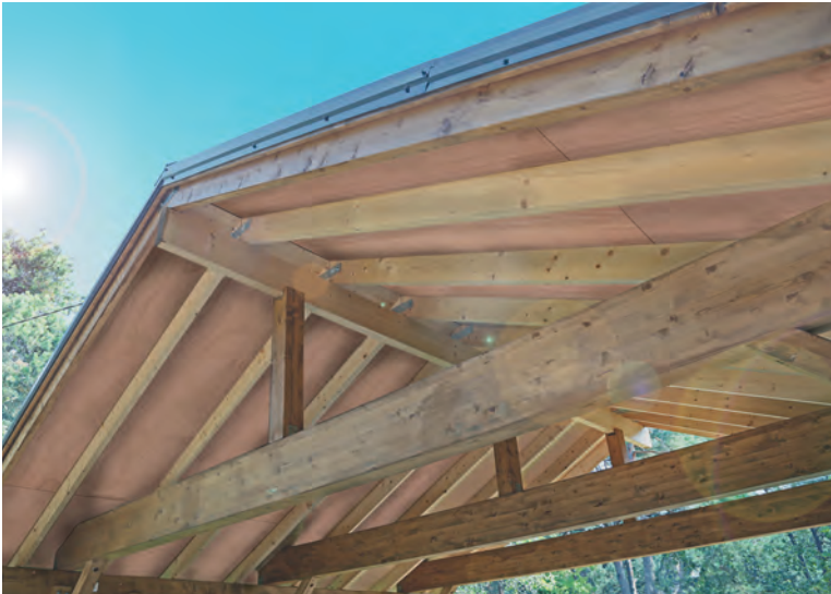
Een carport uitgevoerd met Powerplex Bio. De multiplex plaat is geschikt voor gebruik buiten in beschutte omstandigheden.
